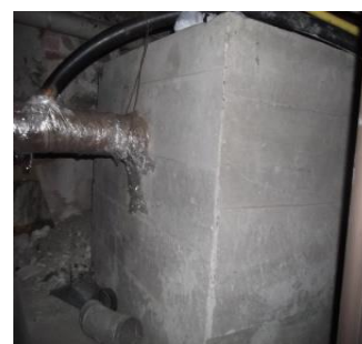
Au sous-sol de la maison
