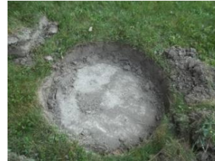
Pas assez déterré
