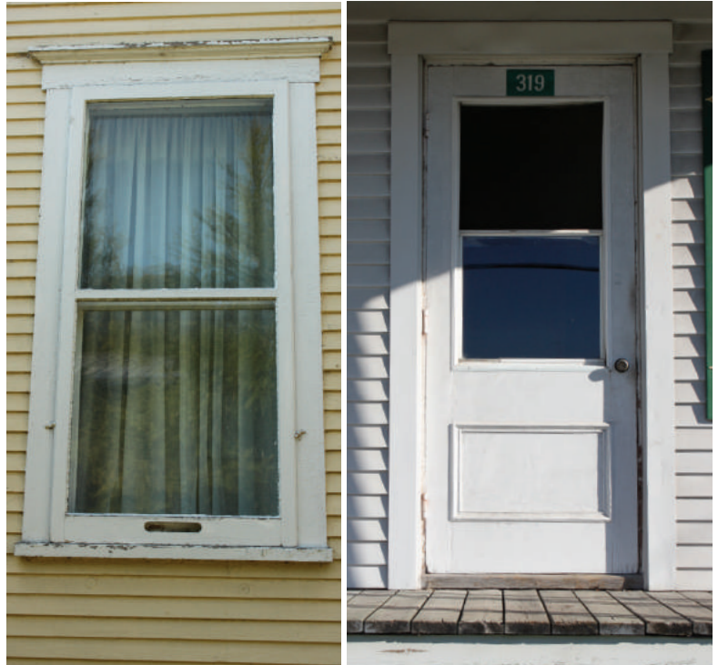
Fenêtres en bois à auvent d'apparence guillotine et porte en bois à la demi vitrée mises en valeur par des chambranles en bois.
