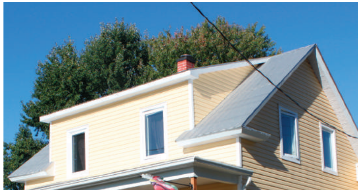
Lucarne rampante centrée sur le versant
