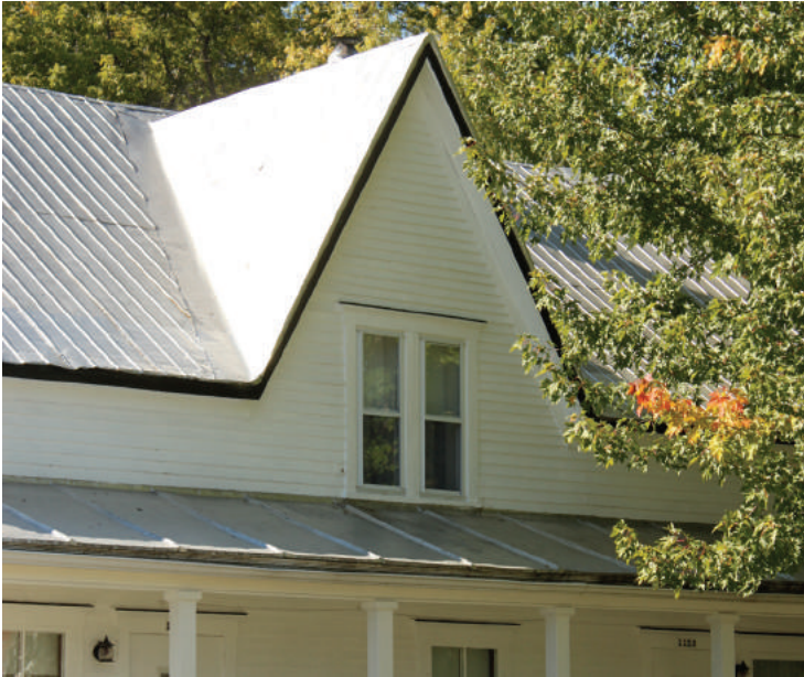
Lucarne-pignon centrée sur la façade
