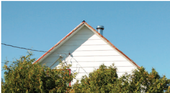
Toiture à deux versants droits d'une pente d'environ 45 degrés
