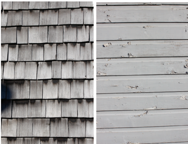
Revêtements muraux : bardeau de bois, planche de bois teint
