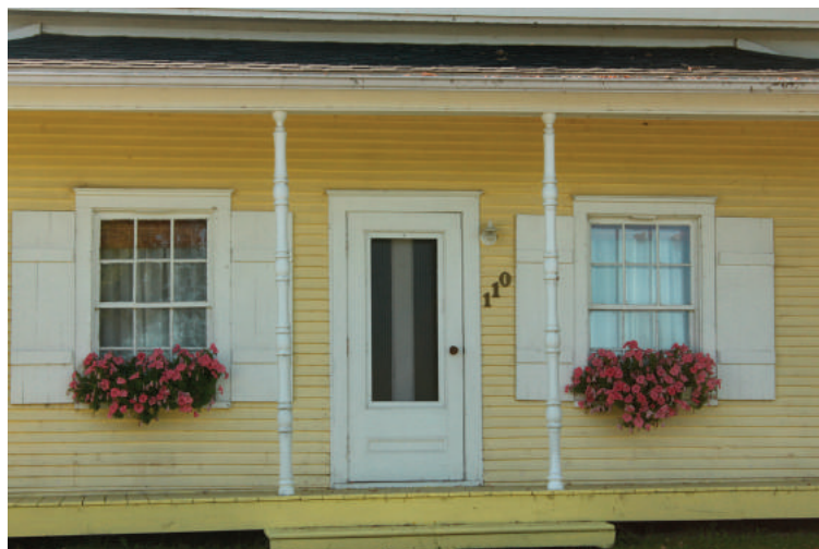
Fenêtres à guillotine en bois à carreaux, les ouvertures sont encadrées de chambranles en bois
