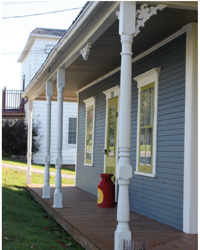
Galerie ornementée de poteaux tournés en bois et de dentelles, exceptionnellement près du sol en raison du dénivelé de celui-ci
