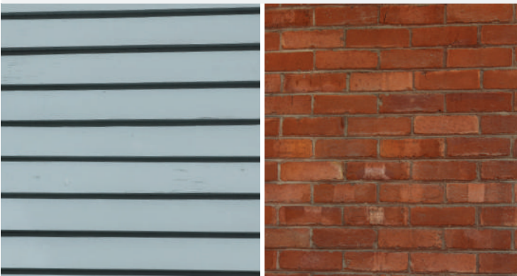
Revêtements muraux : planche de bois à clin teint, brique d'argile
