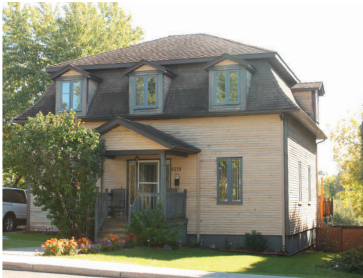
Toit mansardé à quatre versants
