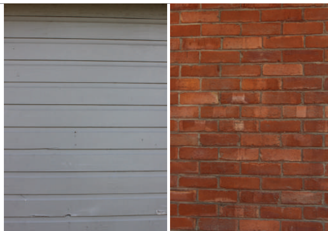
Revêtements muraux : planche de bois teint, brique d'argile
