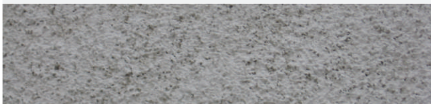
Revêtement mural : crépi artisanal
