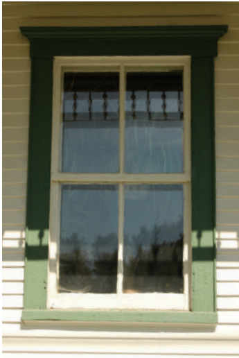
Fenêtres à guillotine ornementées de chambranles en bois
