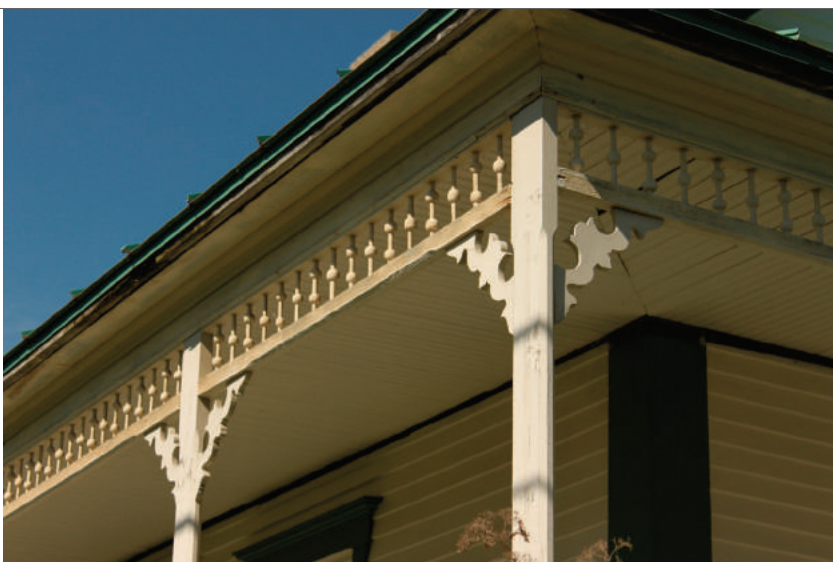
Détails d'une galerie : poteaux chanfreinés, lambrequins et dentelles en bois
