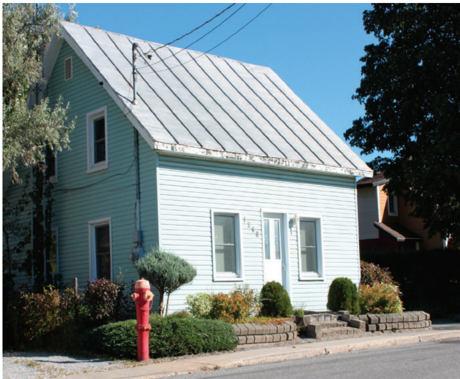
Toiture à deux versants droits couverte d'une tôle à baguettes
