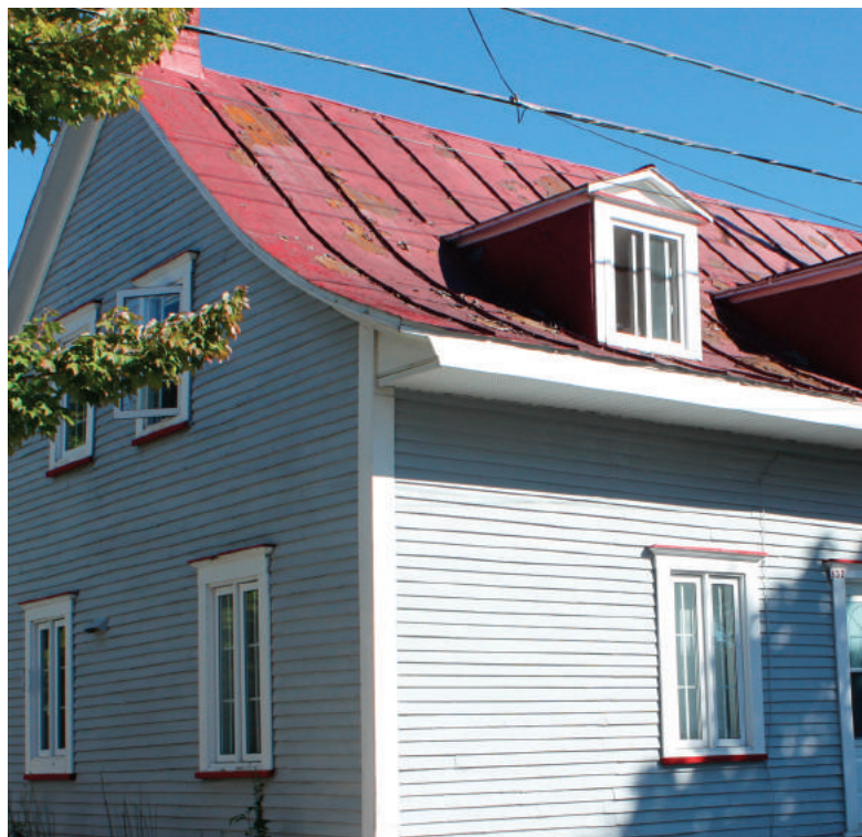
Toiture couverte d'une tôle à baguettes et lucarne à pignon
