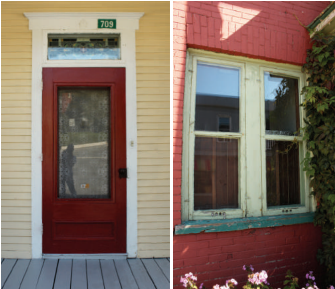
Porte en bois avec imposte mis en valeur par des chambranles en bois et fenêtres jumelées à guillotine en bois
