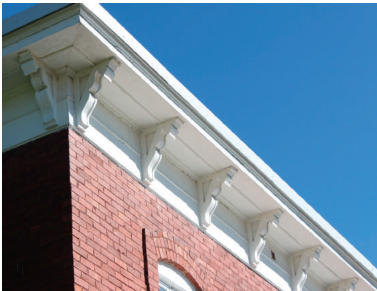
Large corniche avec consoles en bois sous le débord de toit
